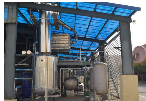
廢水蒸餾設備
